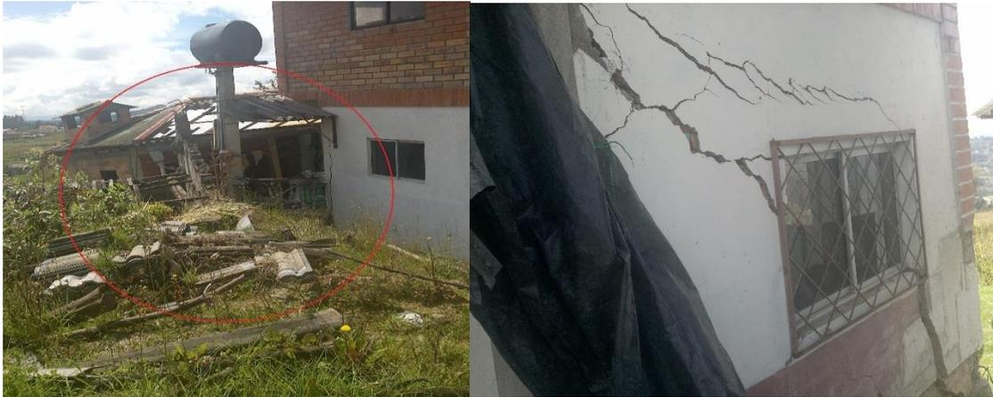
**FOTOGRAFÍA NRO. 37 VIVIENDAS COLAPSADAS Y FALLAS ESTRUCTURALES QUE COMPROMETEN PELIGROSAMENTE LA VIVIENDA 724658-9688139 Y 724667-9688133.**
