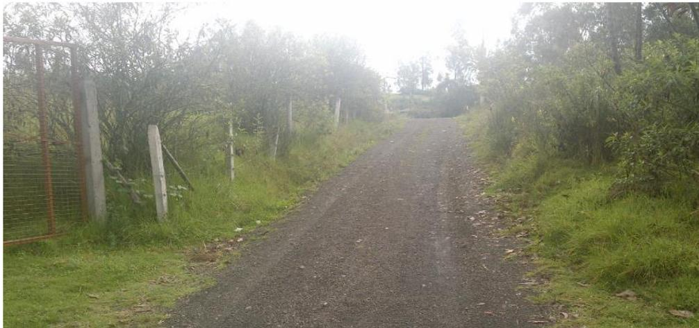
**FOTOGRAFÍA NRO. 24 DESNIVEL EN LA VÍA NOS INDICA QUE EN ESTA ZONA SE GENERÓ UN HUNDIMIENTO DEBIDO A LA ACTIVIDAD DEL DESLIZAMIENTO EN EL AÑO 1995.**
