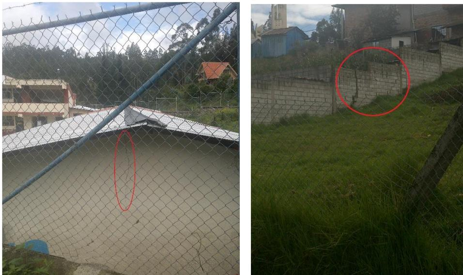
**FOTOGRAFÍA NRO. 31 EVIDENCIAS DE FRACTURAMIENTO EN LA ESCUELA Y ESTRUCTURAS ALEDAÑAS.
