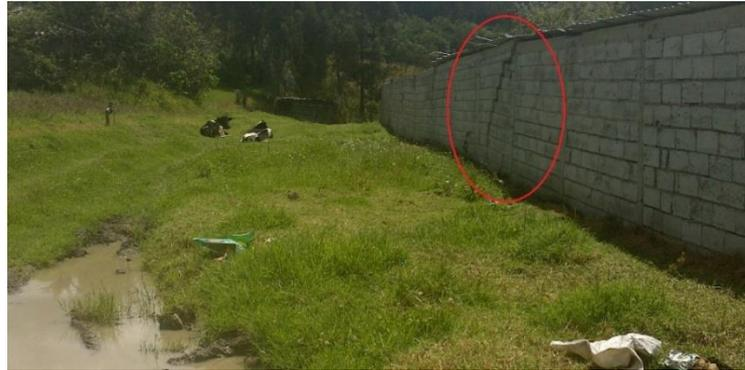
**FOTOGRAFÍA NRO. 40 DESTRUCCIÓN DE UN MURO DEBIDO A SATURACIÓN DE LOS SUELOS Y MAL SISTEMA DE DRENAJE, SE PUEDE OBSERVAR AGUA ACUMULADA QUE DEBERÍA SER DRENADA 725539-9687469.**
