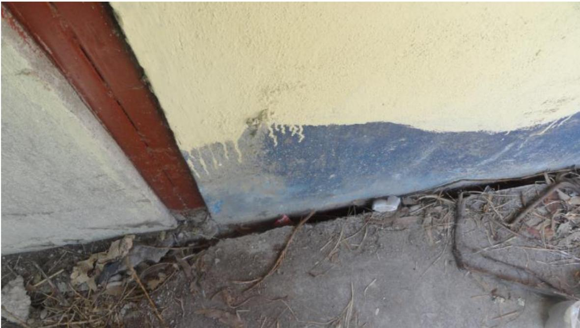
**FOTOGRAFÍA NRO. 29 FRACTURAS QUE EVIDENCIABAN LA ACTIVIDAD DEL MOVIMIENTO EN EL AÑO 2012
