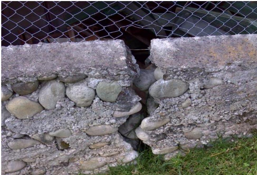
**FOTOGRAFÍA NRO. 30 MURO FRACTURADO QUE INDICABA EL ACCIONAR DEL DESLIZAMIENTO 2012
