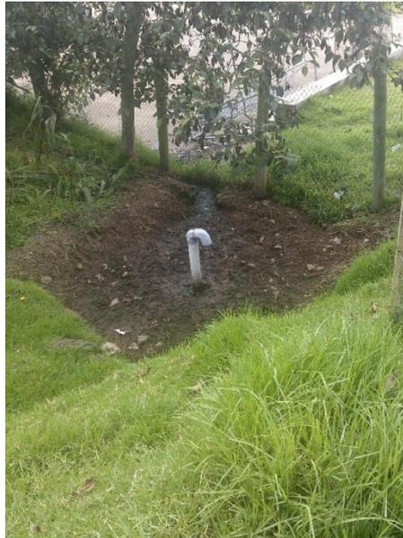
**FOTOGRAFÍA NRO. 39 POZO SÉPTICO COLAPSADO POR FALTA DE MANTENIMIENTO 724693- 9688244**
