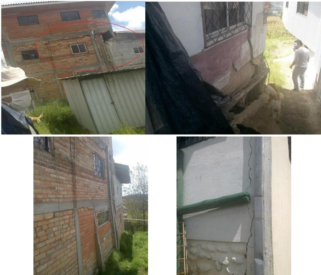
**FOTOGRAFÍA NRO. 38 DAÑOS ESTRUCTURALES QUE PONEN EN DELIO PELIGRO DE COLAPSO, ESTAS VIVIENDAS NO DEBERÍAN ESTAR HABITADAS POR EL INMINENTE PELIGRO DE DESTRUCCIÓN TOTAL.**
