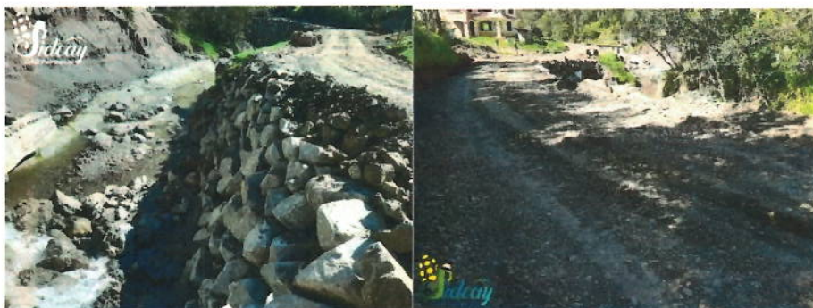
Foto: Programa de Rehabilitación y Mantenimiento Vial
